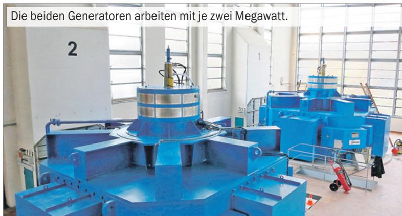
Die beiden Generatoren arbeiten mit je zwei Megawatt.
