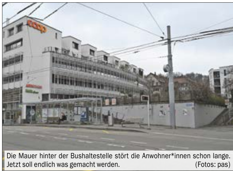
Das Trottoir auf der Südseite der Nordbrücke soll um drei bis fünf Meter verbreitert werden.
