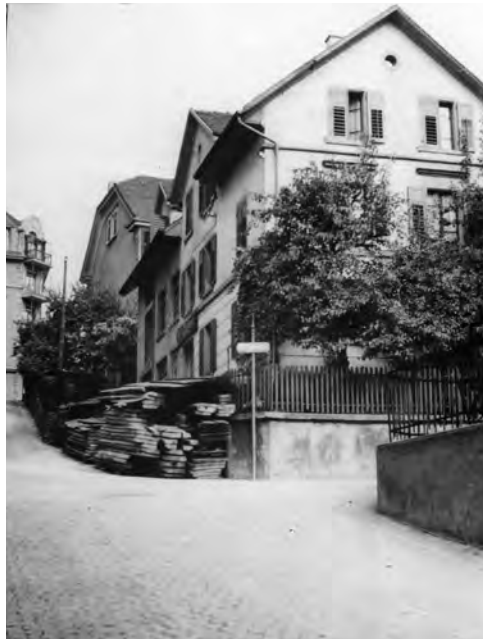
Das Wohnhaus mit der Schreinerei von Jakob Ott an der Burgstrasse 22. (Foto: BAZ)
