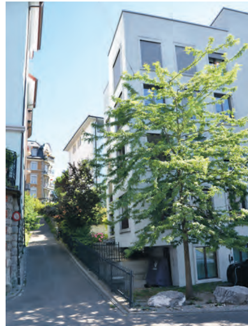
Die Burgstrasse 22 und der Burgsteig heute. (Foto: Kurt Gammeter)
