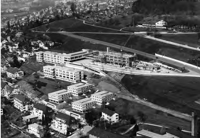
Das Krankenhaus Käferberg wird um einen dritten Bettenhastrakt erweitert. Das Foto wurde im Jahr 1964 aufgenommen. (Fotos: Baugeschichtliches Archiv Zürich)
