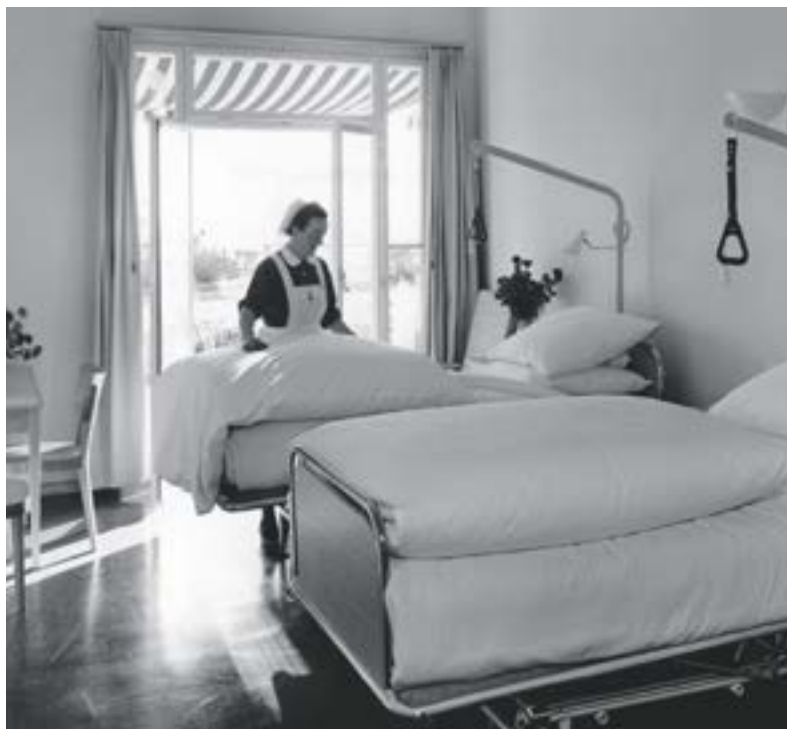
Die Zimmer im Stadthospital Waid sollten ein wohnliches Ambiente verströmen. (Foto: Baugeschichtliches Archiv, Michael Wolgensinger)
