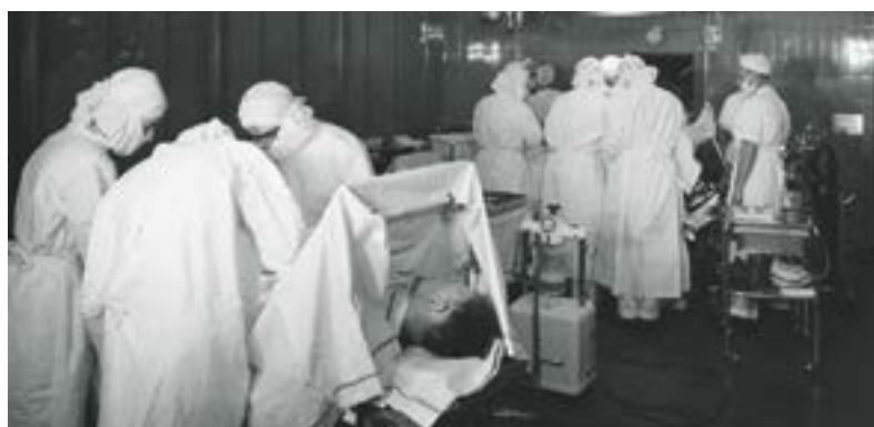
In einem der Operationssäle im Eröffnungsjahr 1953. (Foto: Baugeschichtliches Archiv, Michael Wolgensinger)
