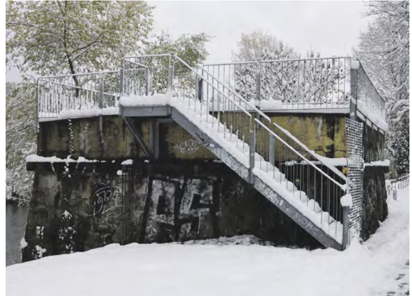
Diese Steinklötze am Sihlquai sind die Überreste der Drahtseil-Transmission. Auf den Sockeln standen die Eisentürme mit den Zahnradern, welche die Kraft über Ketten in die Industriewerke lieferte. Dieser Sockel steht gegenüber dem ehemaligen Pumpwerk am Sihlquai, heute Teil des EWZ. (Foto: Kurt Gammeter, 2024)
