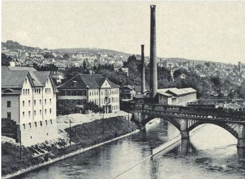
Die Gebäude im Letten erzählen die Geschichte der Spitzentechnologie: in der Mitte die vormalige Hofmeistersche Fabrik, hinter dem Lettenviadukt das Pumpwerk mit den beiden Kaminen der Notstrom-Aggregate und links die Trafo-Station mit dem Umwandler des Stroms für das Hönggertram. (Postkarte von 1908)
