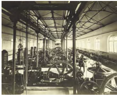
Blick ins Herz des Letten-Kraftwerks: Zahnräder und Zahnstangen übertrugen die Kraft der Turbinen auf den Drahtseilzug. (Foto: Aufnahme von 1880, BAZ)
