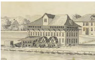
Die Wasserräder der Hofmeisterschen Fabrik im Letten trieben die Walken und Pressen der Kattundruckerei an. Die technische Meisterleistung war der eigens parallel zur Limmat gebaute Kanal. (Bild: Ausschnitt aus dem Aquarell «Herrn Hofmeisters Landgut u. Fabrick ohnweit Zürich» von 1790)
