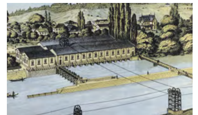
Der Letten als mechanisches Kraftwerk: Das Wasser floss im Kanal seitlich ins Kraftwerk und trieb zehn waagrecht liegende Jonval-Turbinen an. Die Kraftübertragung erfolgte über ein Zahnradgetriebe auf die Drahtseil-Konstruktion. (Ausschnitt aus einem Kalender von 1878)
