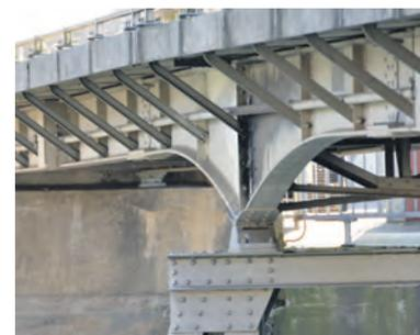
Der Dammsteg mit Blick Richtung Sihlquai: Diese Leitung seitlich ist keine Wasserleitung, sondern ein Relikt der Verteidigungsstellung von 1940: Das Rohr war damals mit Sprengstoff gefüllt. In den Schlaufkästen (die beiden senkrecht stehenden Kästen rechts und links im Bild) lag die Sprengvorrichtung mit dem Zünder. (Foto: Kurt Gammeter, 2002).
